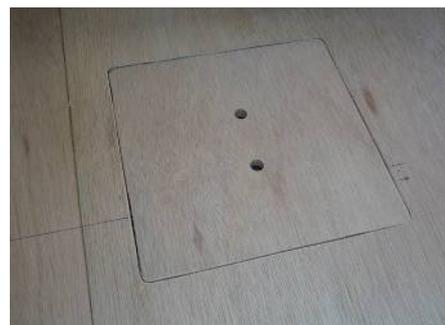
↑ 燃料タンクのメンテナンスのために点検口も設けてあります。折角なので切り抜いた板をそのままフタにした。最初のノコ入れに成功すれば簡単です。
